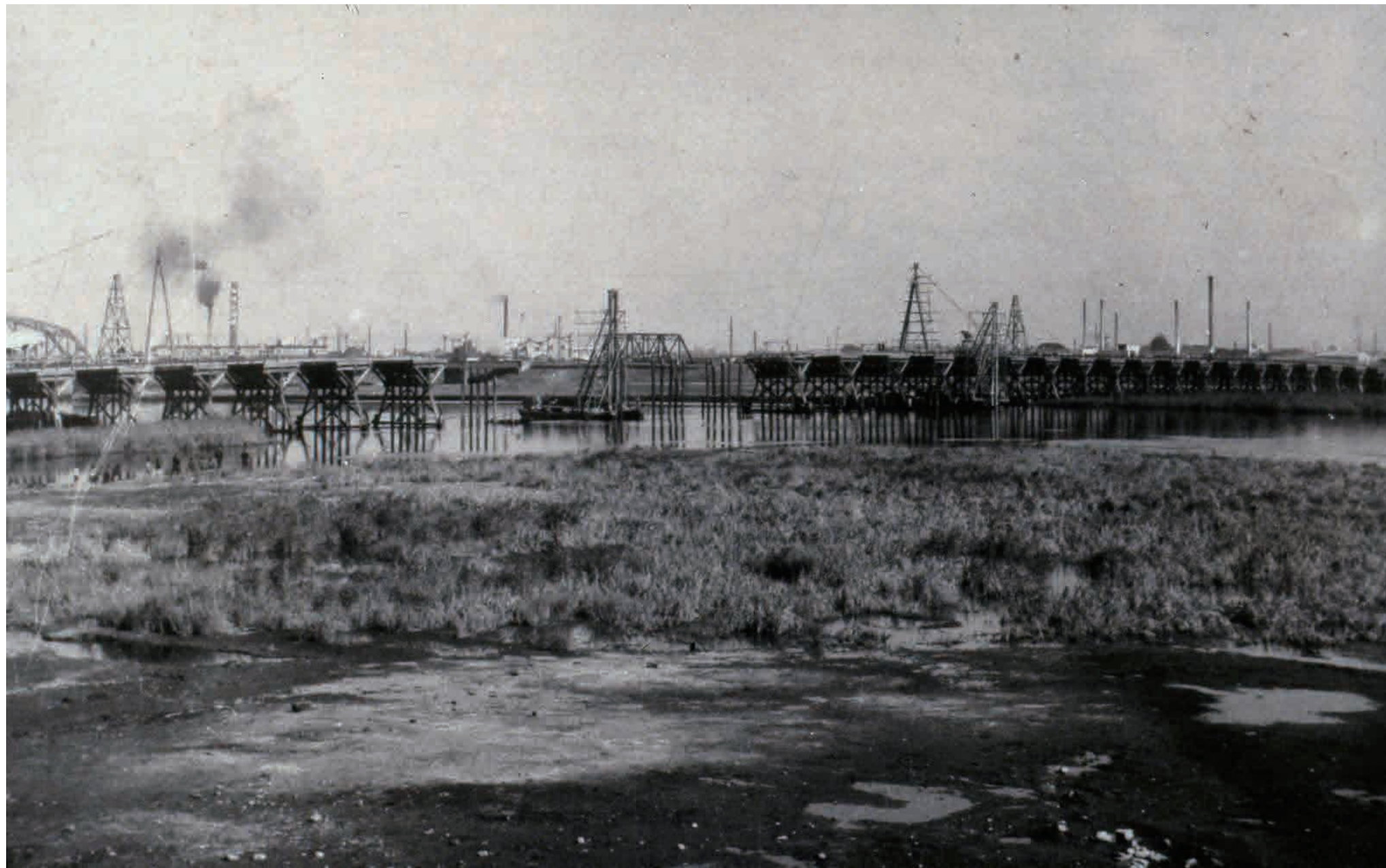
初代堀切橋の解体撤去 (出典) 足立区立郷土資料館収蔵資料データベース
