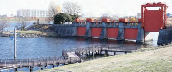
荒川ロックゲートは船を通すため水位を調整するよ!
