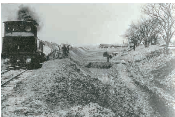
荒川放水路工事
